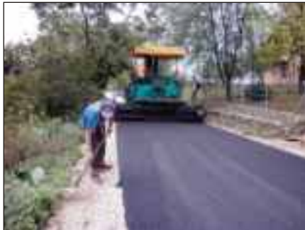
Asfaltiranje puta u MZ Bobare-Drinčići-Blaževci
